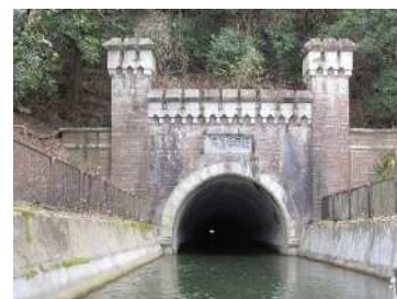
第三隧道（東口）
