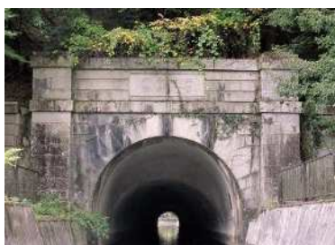
第二隧道（東口）
